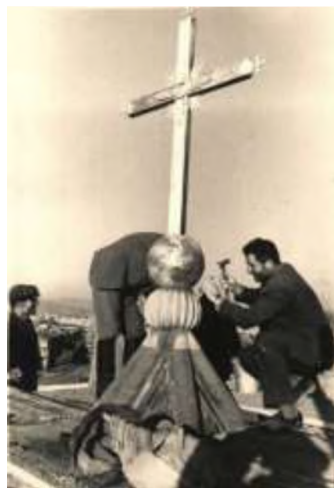
Илл. 3. Бригада Мукуча Мхитаряна во время восстановления колокольни храма Всеспасителя, 1965. Источник: URL: http://cfa.am/en/construction-masters (дата обращения: 31.03.2020).
