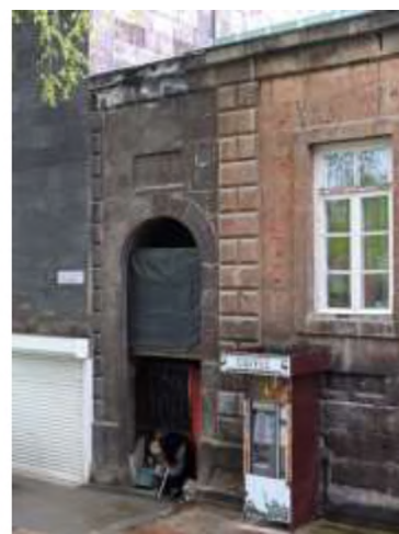
Илл. 22. Арка между модернистским и историческим зданиями из черного туфа. Фото автора, 2019
