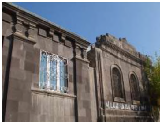
Илл. 20. Новый и старый дома из черного туфа на улице Шираза. Фото автора, 2018
