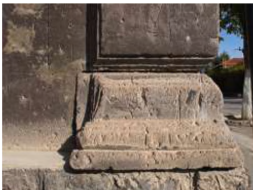
Илл. 17. Дом 146 по ул. Гукасяна. Деталь. Фото автора, 2018
